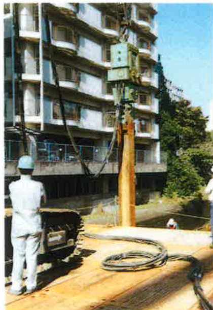
名古屋市役所土木局 名古屋市中区 都市小河川新堀川 改修工事 H350×13.5m 土質:シルト N値:10
