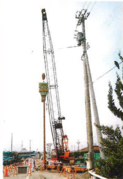
建設省北陸地方建設局 富山県下新川郡朝日町 交差点新設工事 鋼矢板Ⅳ-12m 土質:玉石(最大径φ500) N=50/6 ウォータージェット 300PSクラス1台併用
