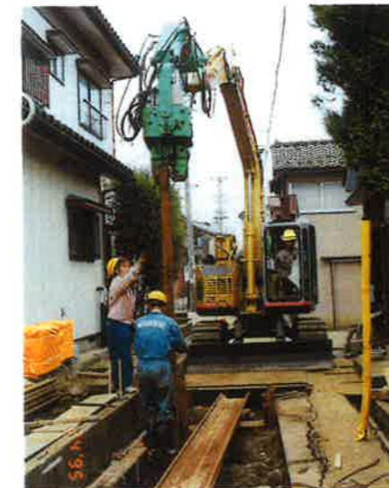
PALSONIC-2B 新潟県三条市役所 下水道課 下水道枝線工事 軽量鋼矢板Ⅲ型-4.5m ベースマシン:0.2㎡ 土質:砂 N値:8
