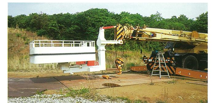
SS-300 50Tラフター取付
